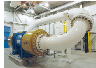
Рисунок 3 – Общий вид нового поколения регулируемых электроприводов ЭГПА-9,2/8600-56/1, 44-Р
