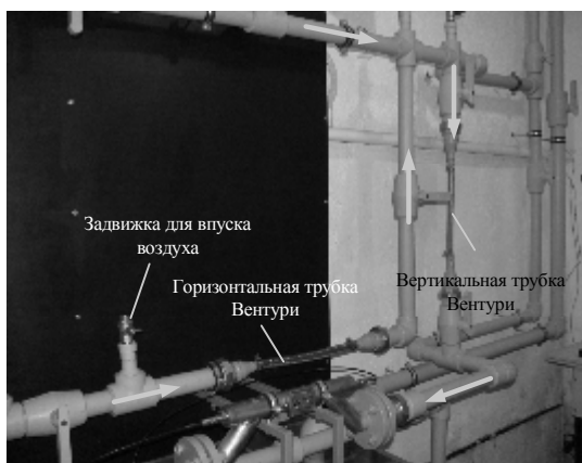
Рисунок 4 – Установка трубок Вентури
